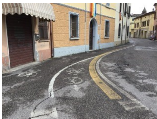
Via Giuseppe Garibaldi – lungo tratto urbano che conduce al centro con percorsi ciclopeditone protetto solo da una linea gialla a terra
