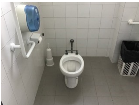
Ex Ospizio Bedeschi – assenza di maniglioni a lato della tazza wc, mancanza di schienale
