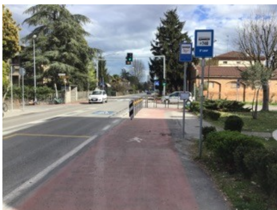
Via Chiusa – fermata a raso inadeguata in quanto manca segnaletica podotattile di orientamento, palina intelligente, piattaforma ad altezza adeguata, pensilina
