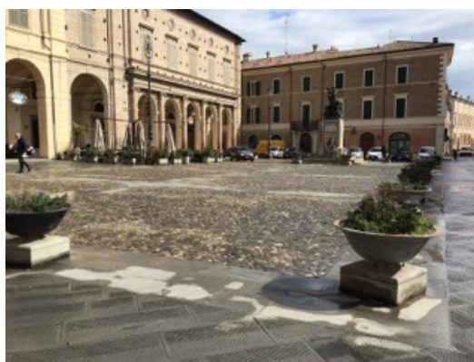
Piazza della Libertà – manca una chiara definizione degli spazi pedonali protetti e non sono presenti attraversamenti pedonali
