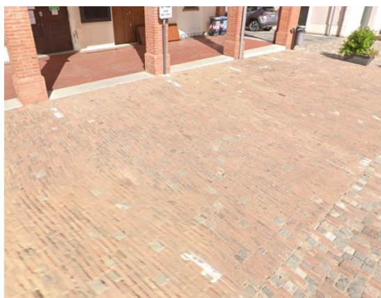
Piazza Marconi – particolare del raccordo tra la pavimentazione della piazza e il porticato del Municipio e della segnaletica utilizzata per delimitare i parcheggi
