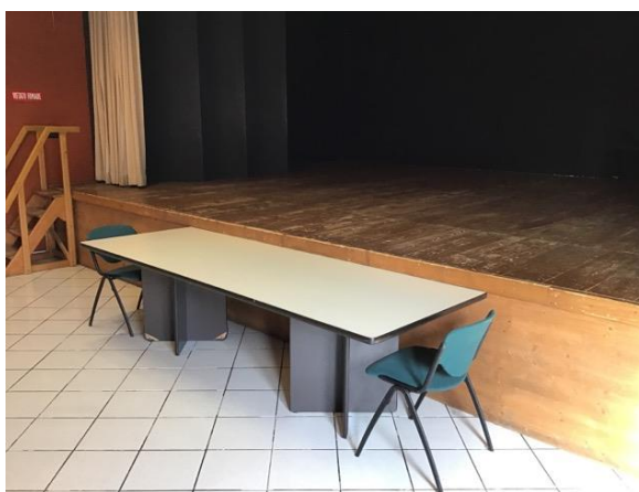
Sala Polivalente – mancanza di percorso accessibile per accedere al palco
