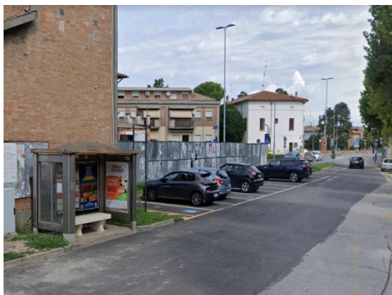
Via Pilastrino – il parcheggio riservato e la pensilina di attesa del bus sono poste sul lato opposto della strada rispetto le paline, inoltre non è presente alcun tipo di percorso protetto né di attraversamento pedonale
