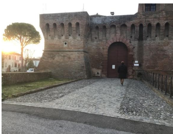
Via Camangi – particolare del percorso in ciottolato con fascia centrale, accessibile, in cubetti di porfido posati in maniera adeguata
