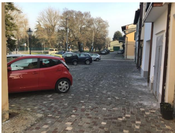
Via Terraglio a Settentrione – mancanza di segnaletica a terra che indichi la presenza di un percorso pedonale protetto e gli stalli di sosta dei veicoli
