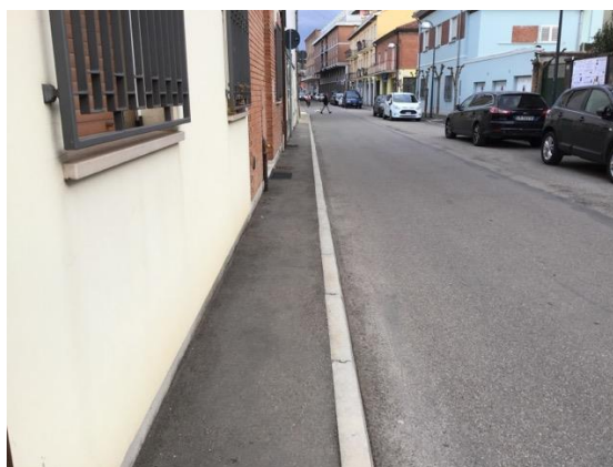
Via Giuseppe Garibaldi - marciapiede di recente realizzazione larghezza inferiore a 90cm
