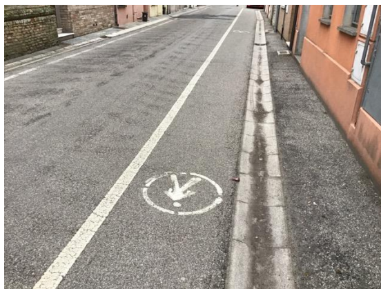
Corso Sforza - percorso a raso indicato solo da una linea terra, andrebbe maggiormente protetto con elementi dissuasori.
