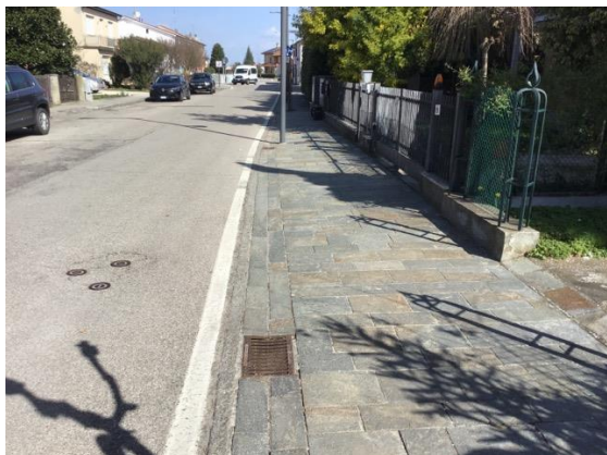
Via Manzoni Barbiano – nuovo percorso pedonale, pendenza trasversale superiore all'1%
