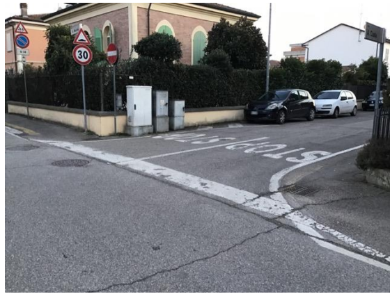
Via Giuseppe Mazzini – assenza di attraversamento pedonale
