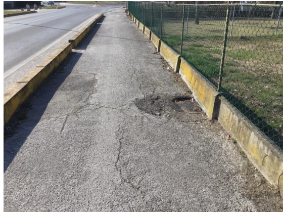
Via Bastia – dettaglio del percorso ciclopedonale a raso protetto da un cordolo in cls verniciato di giallo
