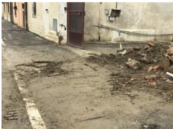
Via Camillo Benso di Cavour – alcuni segni evidenti dell'alluvione con materiale misto fango depositato a bordo strada
