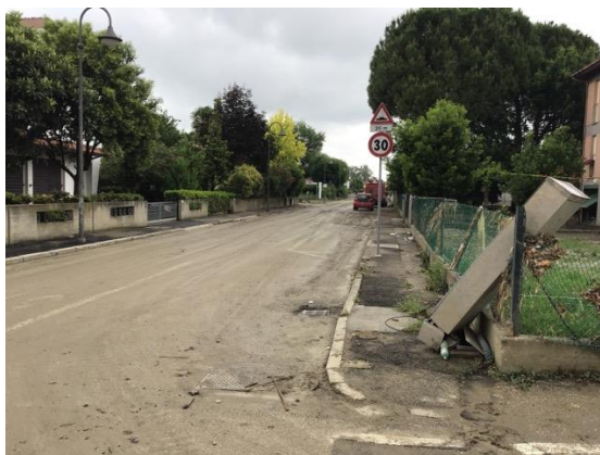
Via Salvador Allende – parziale peggioramento della superficie di calpestio, manufatti tecnologici divelti dalla forza dell'acqua
