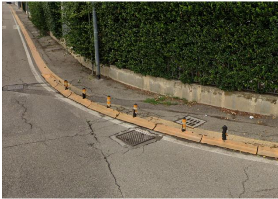
Via Benedetto Cairoli/via Ospedaletto – dettaglio del cordolo giallo a protezione del percorso pedonale
