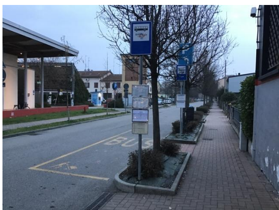
Via Cesare Battisti – assenza di una fermata accessibile, mancanza di una piattaforma rialzata.
