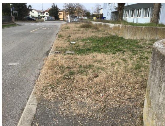
Via Italia – completa assenza di un percorso pedonale accessibile davanti alla scuola media di Lavezzola
