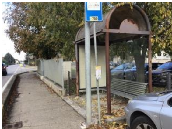
Via Reale – fermata in trincea a raso, separata dalla strada da una cordonata e dalla pista ciclopedonale
