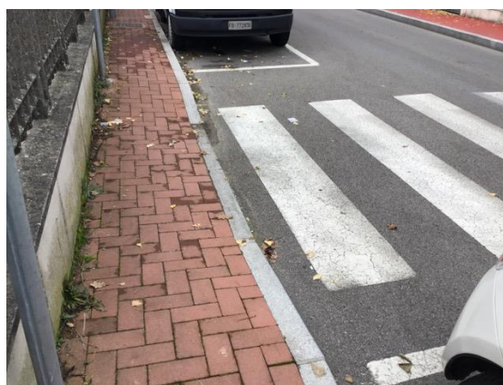
Via Terzo Lori – percorso pedonale in rilevato in massello autobloccante, con rampa adeguata in corrispondenza dell'attraversamento | manca la segnaletica tattile di orientamento
