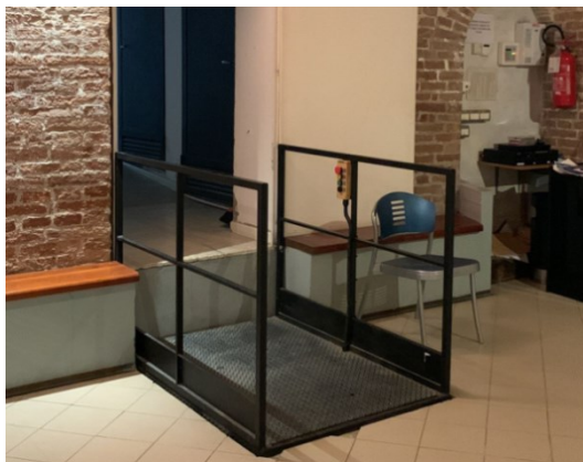
Biblioteca + Granaio – piccola piattaforma elevatrice per superare il dislivello di 47 cm
