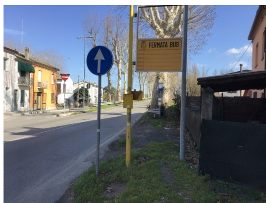
Via Martiri – fermata inaccessibile, senza percorso pedonale di collegamento né piattaforma
