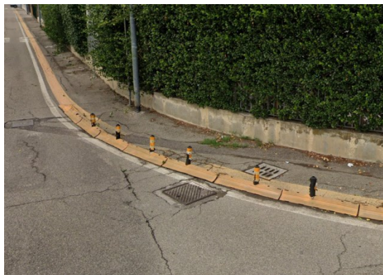
Via Benedetto Cairoli/via Ospedaletto | Sant'Agata sul Santerno – esempio di dettaglio del cordolo giallo a protezione del percorso pedonale 1
