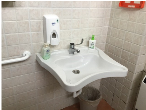
Centro Civico San Savino – Rubinetteria con leva lunga e assenza di specchio
