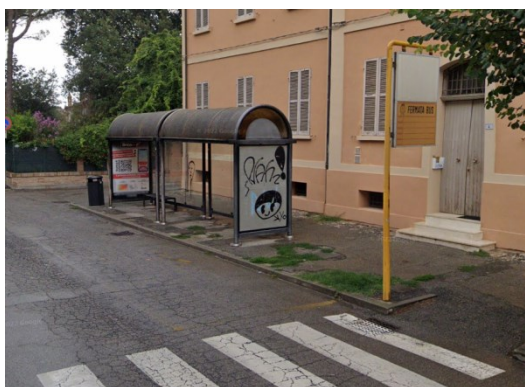
Via Vincenzo Monti – Fermata inadeguata per presenza di pavimentazione sconnessa, pensilina troppo in prossimità della cordonata, palina non intelligente, mancanza di segnaletica podotattile di orientamento
