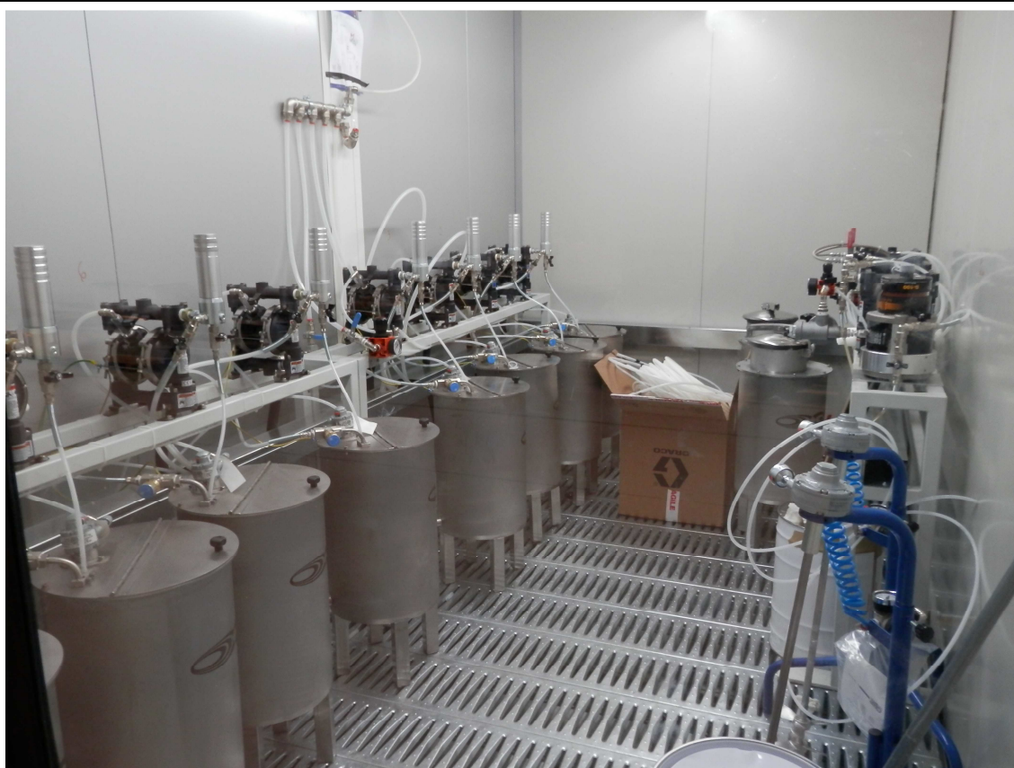
Esempio di vista interna locale di alimentazione e distribuzione vernici
