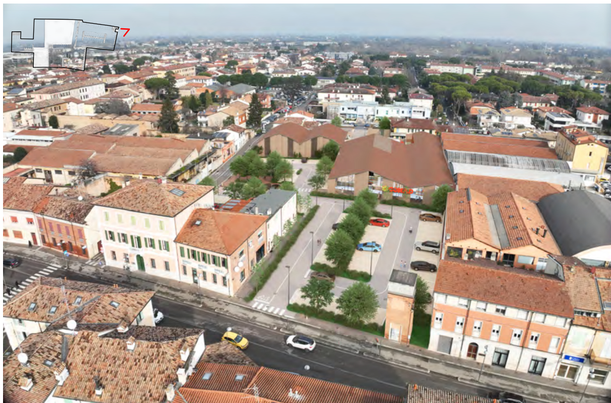
FOTO DRONE DA VIA A. ACQUACALDA STATO PROGETTO
