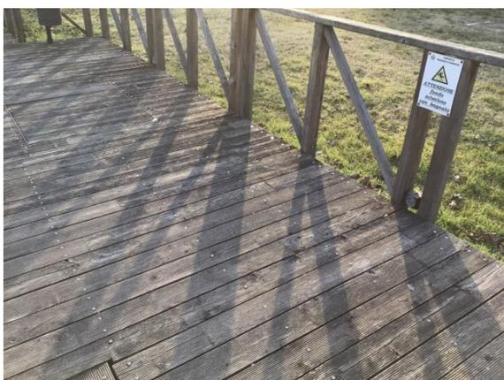
*Viale Giacomo Matteotti – particolare del percorso con pavimentazione in listelli di legno con cartello di avviso che ne indica la scivolosità quando bagnato*
