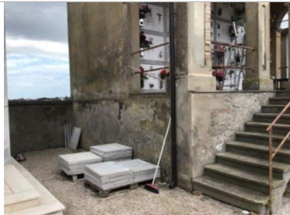
*Cimitero Villanova – assenza di collegamento accessibile tra le due quote, mancanza di differenziazione cromatica e segnaletica podotattile di orientamento sulle scale, pavimentazione in ghiaio sciolto non fruibile*
