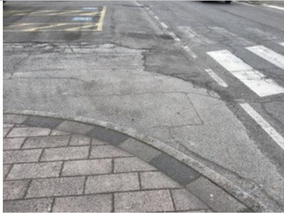
*Via della Chiesa – assenza di percorsi pedonali sicuri in corrispondenza dei parcheggi riservati, di segnaletica podotattile di orientamento in corrispondenza dell'attraversamento, pavimentazione sconnessa*
