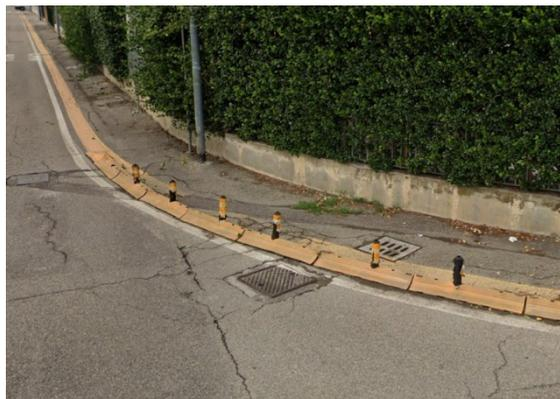
**Via Benedetto Cairoli/via Ospedaletto | Sant'Agata sul Santerno – esempio di dettaglio del cordolo giallo a protezione del percorso pedonale<sup>1</sup>**
