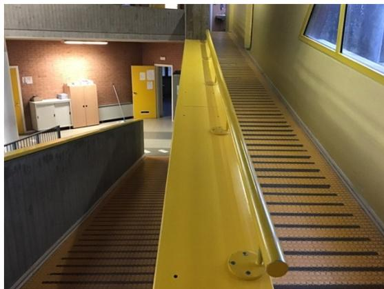
*Scuola primaria – rampe inadeguate per lunghezza, mancanza di piazzole di sosta ogni 10 metri e quantità insufficiente di corrimano*
