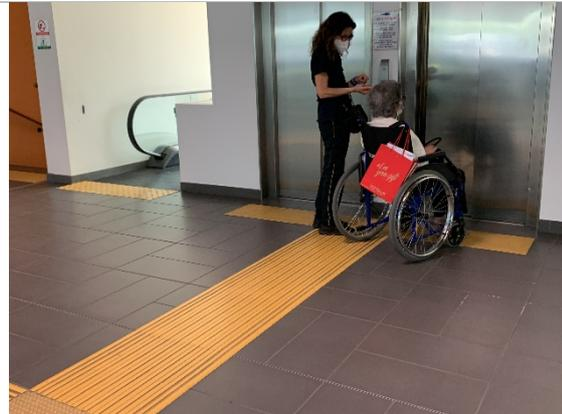
***Esempio di buone prassi per la realizzazione di una efficiente segnaletica tattile a pavimento di intercettazione di un servizio, in questo caso l'ascensore, utilizzando in codice LVE.***
