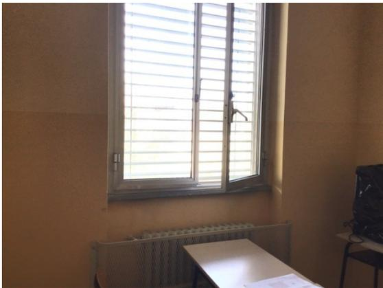
*Scuola elementare di Lavezzola – serramenti dell'intero edificio in alluminio con spigoli vivi, proposta l'integrale sostituzione*
