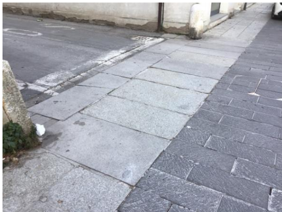
Piazza Matteotti – attraversamenti pedonali in pietra nobile senza zebra e segnaletica podotattile
