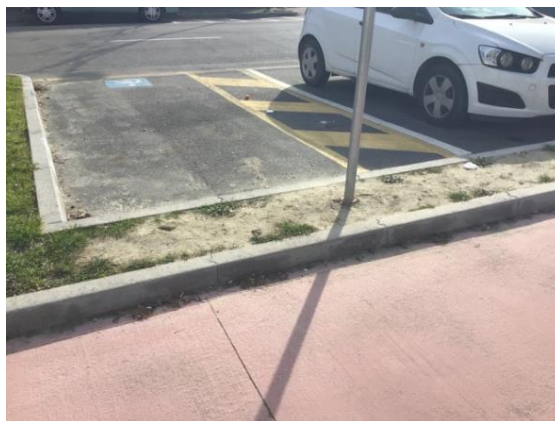
Viale Luigi Quadri – presenza di parcheggio riservato ma non accessibile per presenza di cordona
