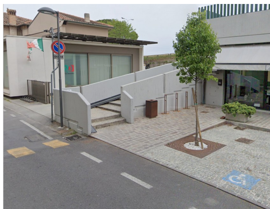
Via Matteotti – interruzione del marciapiede in corrispondenza della scala per andare sull'argine del Senio, il pedone deve invadere la carreggiata.
