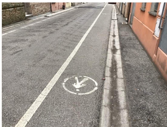
Corso Sforza – percorso a raso indicato solo da una linea terra, andrebbe maggiormente protetto con elementi dissuasori.
