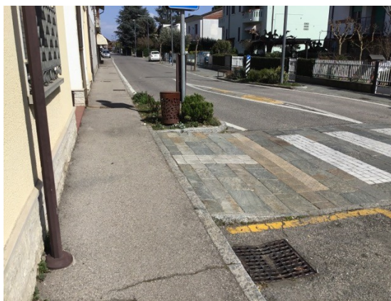
Via Manzoni Barbiano – esempio di segnaletica tattile incompleta, il pedone in transito sul marciapiede non rileva le linee di intercettazione
