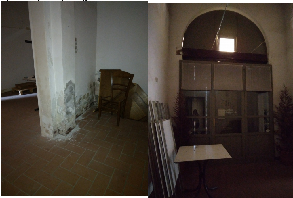
STANZA 3 (lato uscita su via cesare battisti) – presenza di macchie di umidità – problemi apertura porta per rigonfiamento
