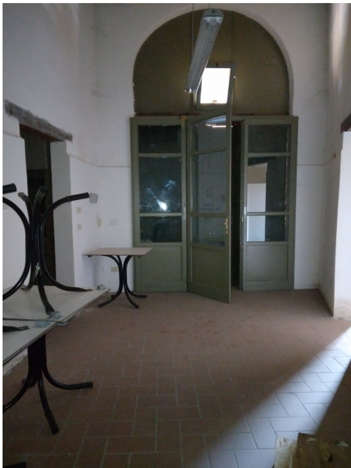
STANZA 3 (lato uscita su via cesare battisti) – presenza di macchie di umidità – problemi apertura porta per rigonfiamento
